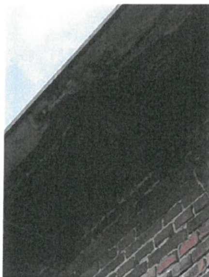
Zdjęcie nr 1 – zawilgocony, uszkodzony okap budynku
