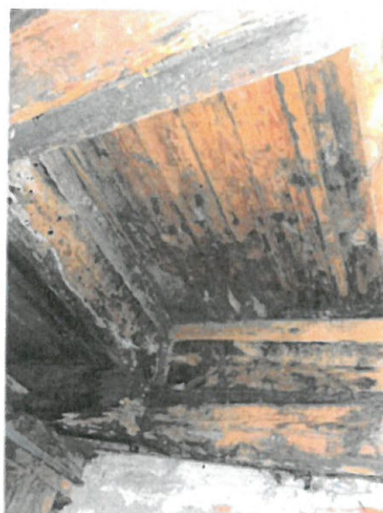
Zdjęcie nr 4 – zawilgocone, uszkodzone, spróchniałe elementy konstrukcji drewnianej dachu budynku – wylaz dachowy
