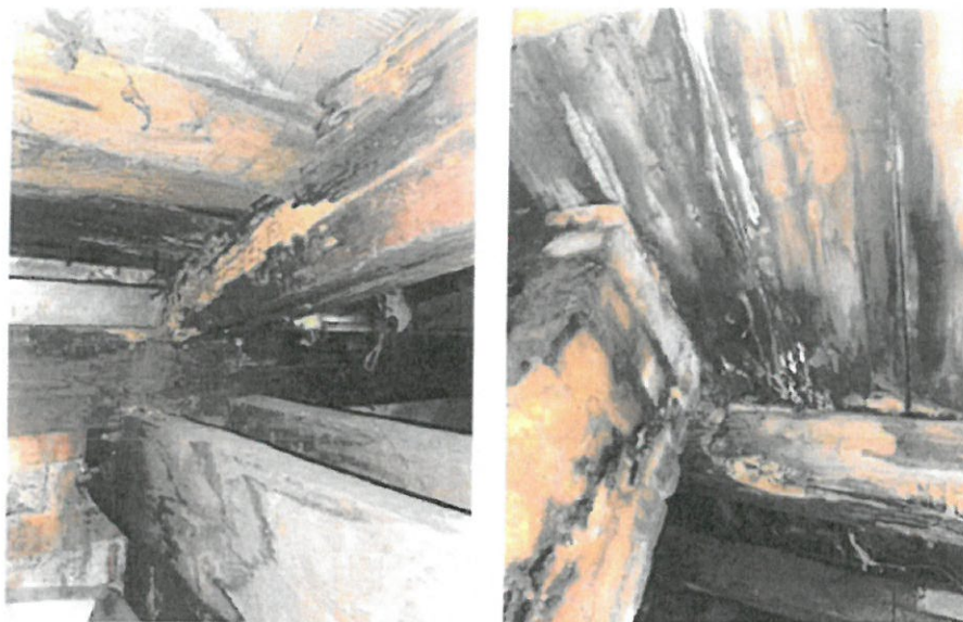
Zdjęcie nr 2 i 3 – zawilgocone, uszkodzone, spróchniałe elementy konstrukcji drewnianej dachu budynku
