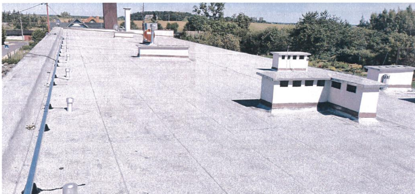
Rys. 3 Widok stropodachu zaizolowanego płytami styropianu z pokryciem z papy.
