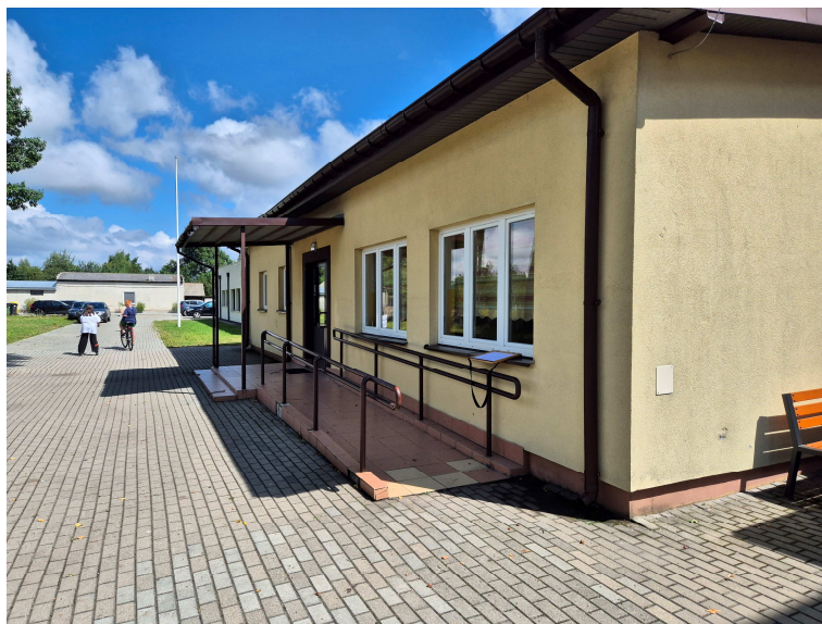
Fot. nr 1 Pochylnia dla niepełnosprawnych wraz ze schodami zewnętrznymi przy wejściu bocznym – do rozbiórki
