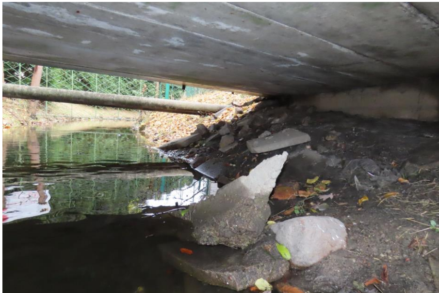
Fot. 1.4. Widok koryta rzeki pod mostem
