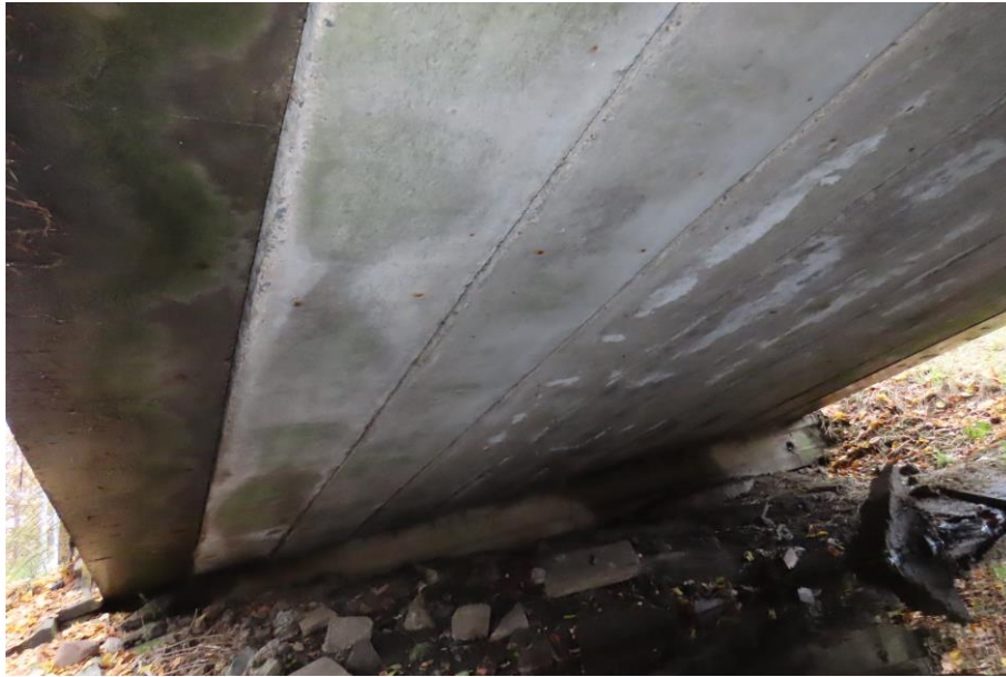
Fot. 1.3. Widok spodu ustroju nośnego i podpory prawobrzeżnej
