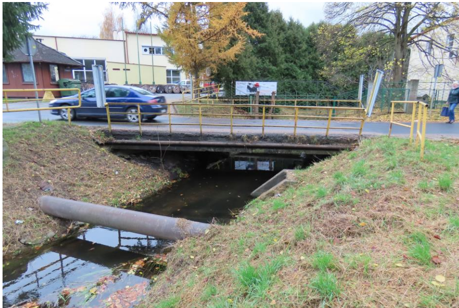
Fot. 1.2. Widok mostu od strony górnej wody
