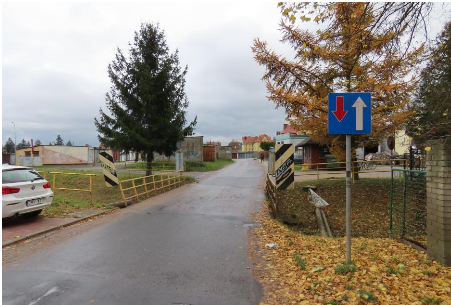
Fot. 1.1. Widok na jezdnię na obiekcie
