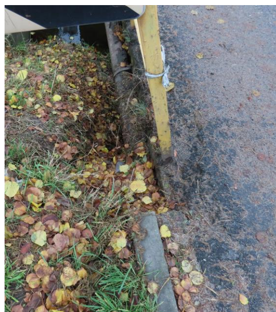
Fot. 2.8. Ubytki i przemieszczenia prefabrykatów ścieków skarpowych – typowe uszkodzenia odwodnienia
