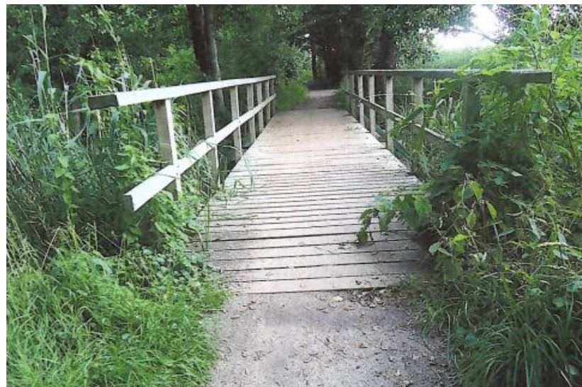
Zdjęcie nr 26 – ul. Chłodna, ścieżka za MOSIR-em, dz. 2588/1, 2587/1
