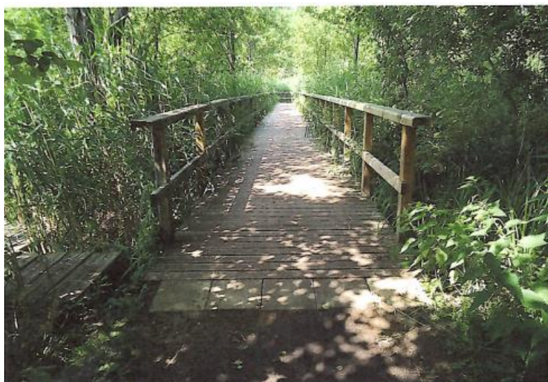
Zdjęcie nr 27 - ul. Chłodna, ścieżka za MOSIR-em, dz. 2400
