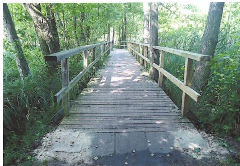
Zdjęcie nr 28 - ul. Chłodna, ścieżka za MOSIR-em, dz. 4497/12 ,2400
