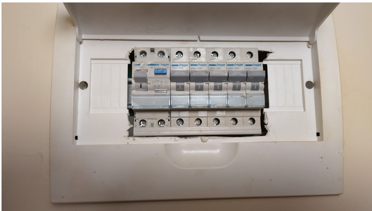
Zdjęcie nr 1: Istniejąca rozdzielnica RM – do demontażu.
