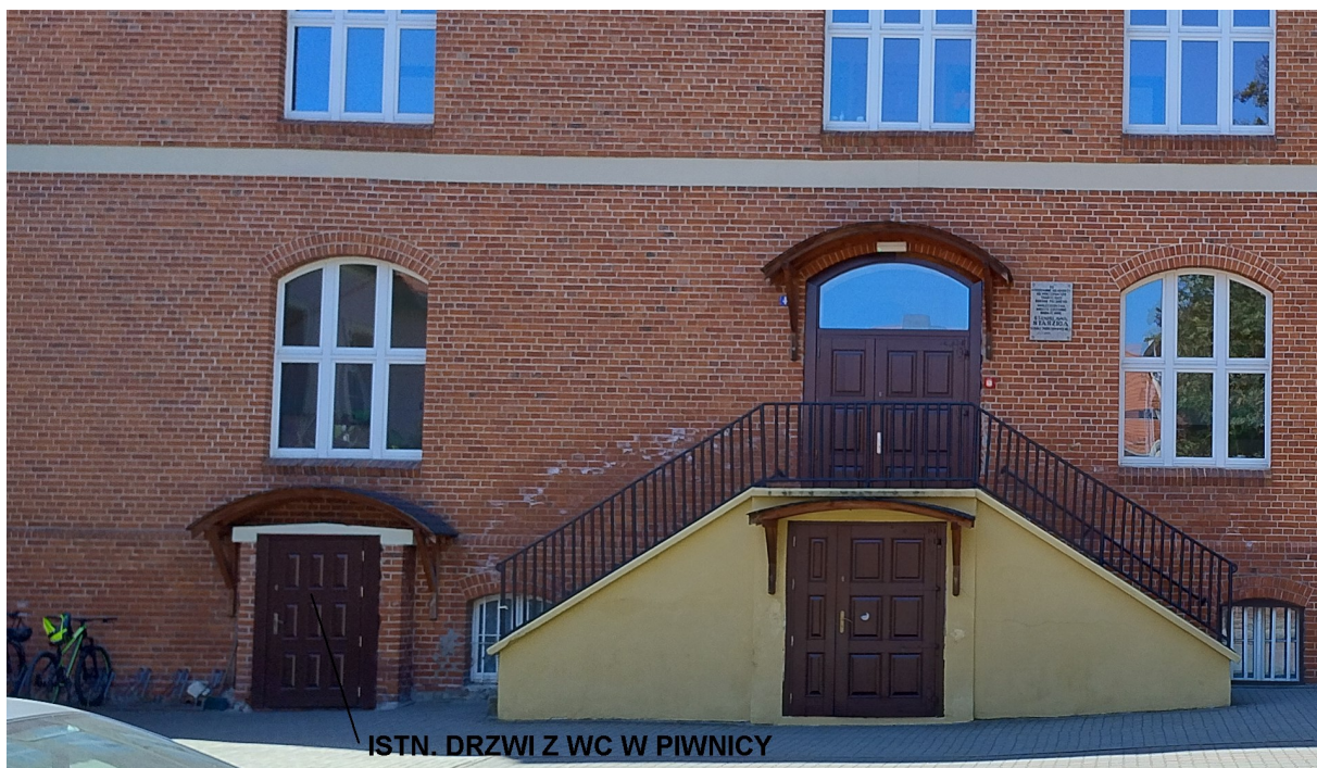
Zdjęcie nr 2: Drzwi z WC w piwnicy – nad drzwiami zabudować oprawę awaryjno-sieciową.
