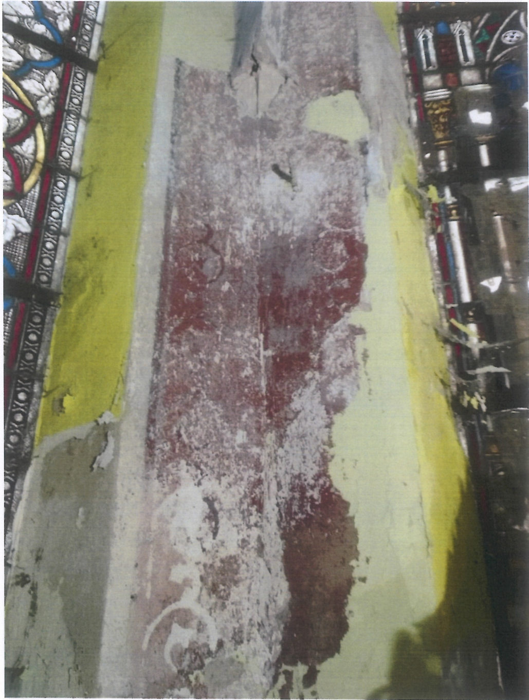
Fot. 111 (wyk. W. Tomaszewski): Odkrywka wykonana na ścianie międzyokiennej w prezbiterium.
