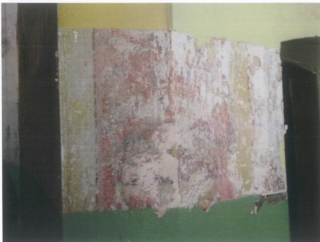
Fot. 116 (wyk. W. Tomaszewski): Odkrywka wykonana po drugiej stronie łuku tęczęowego od strony prezbiterium.
