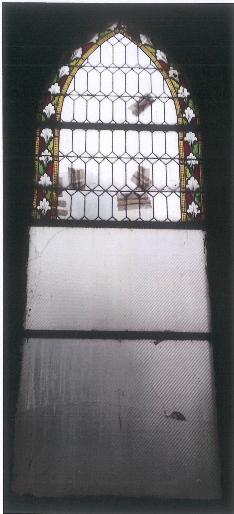
Fot. 132 (wyk. W. Tomaszewski): Stan zachowania witrażu w oknie na elewacji północnej (od wewnątrz).
