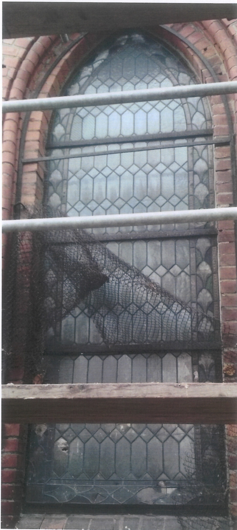
Fot. 129 (wyk. W. Tomaszewski): Stan zachowania witrażu w oknie na elewacji południowej (od zewnątrz).
