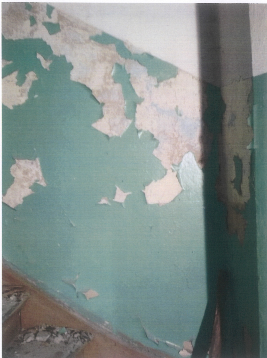
Fot. 83 (wyk. W. Tomaszewski): Widok złączającej się lamperii wykonanej farbą olejną.
