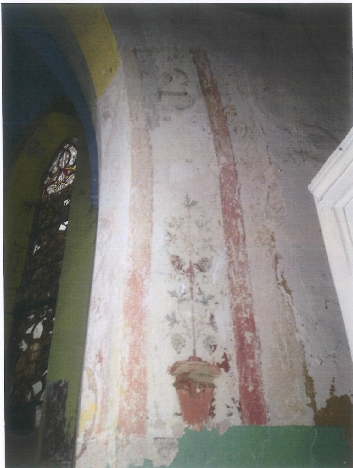
Fot. 102 (wyk. W. Tomaszewski): Odkrywka wykonana na odcinku łuku tęczowego (ściana zachodnia).
