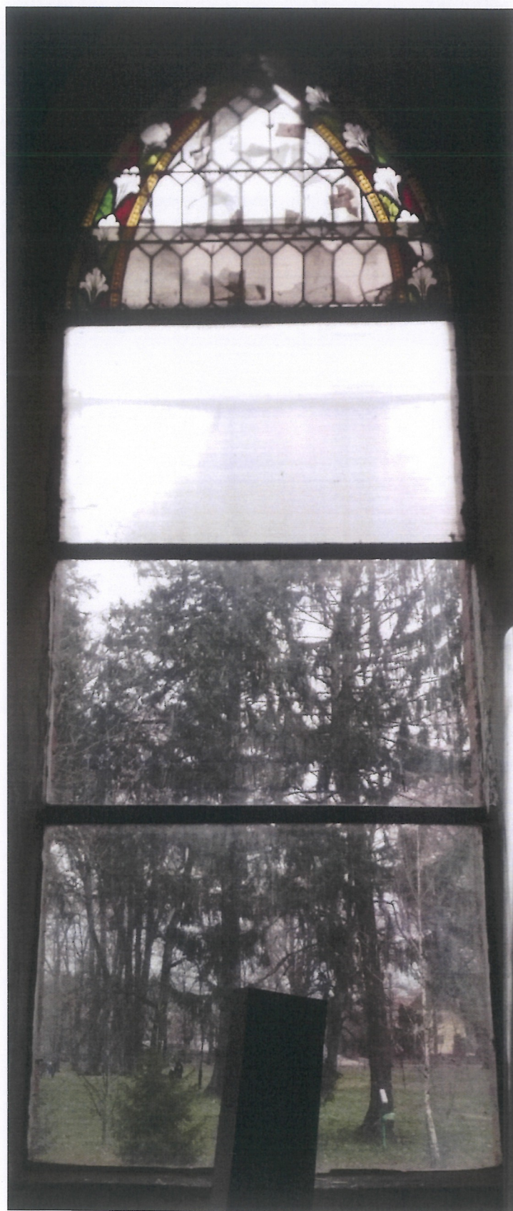
Fot. 134 (wyk. W. Tomaszewski): Stan zachowania witrażu w oknie na elewacji północnej (od wewnątrz).
