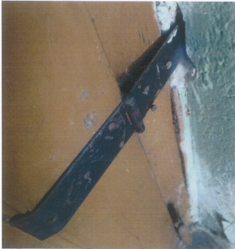
Fot.73 i 74 (wyk. W. Tomaszewski): Rozluźnienia i wyłamania metalowych zawiasów drzwiowych.
