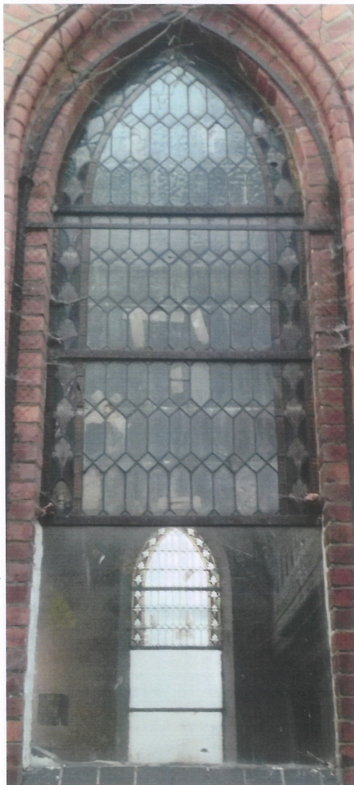
Fot. 127 (wyk. W. Tomaszewski): Stan zachowania witrażu w oknie na elewacji południowej (od zewnątrz).
