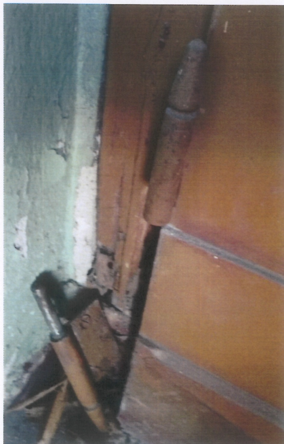
Fot.73 i 74 (wyk. W. Tomaszewski): Rozluźnienia i wyłamania metalowych zawiasów drzwiowych.
