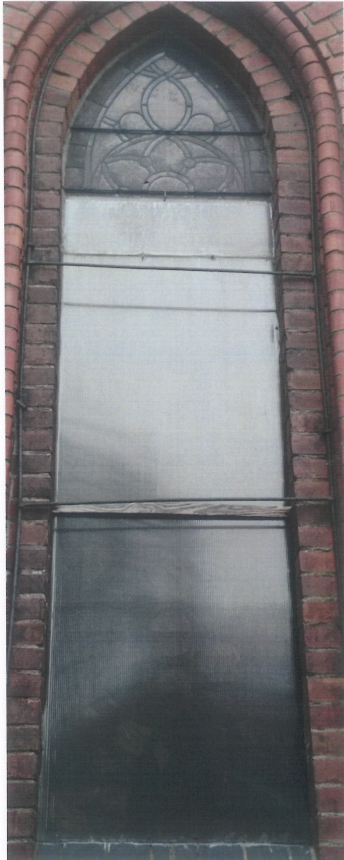
Fot. 125 (wyk. W. Tomaszewski): Stan zachowania witrażu z prawego okna prezbiterium (od zewnątrz).
