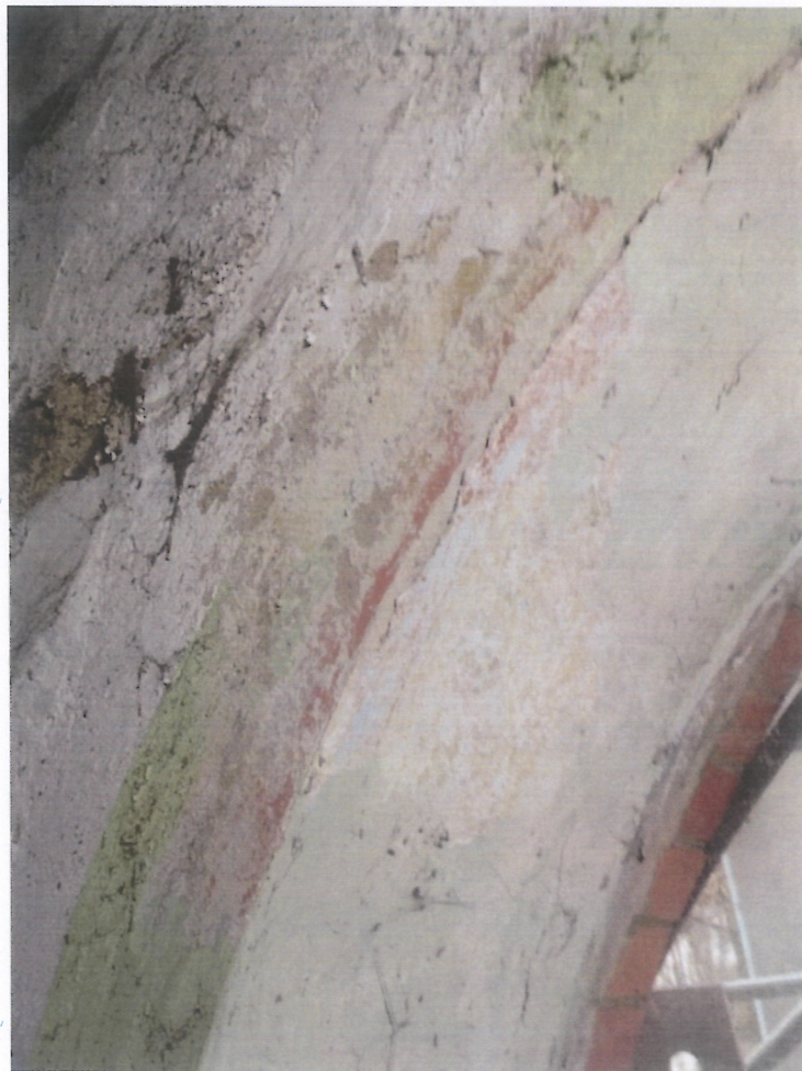
Fot. 99 (wyk. W. Tomaszewski): Odkrywka we wnęcie okiennej na ścianie północnej.
