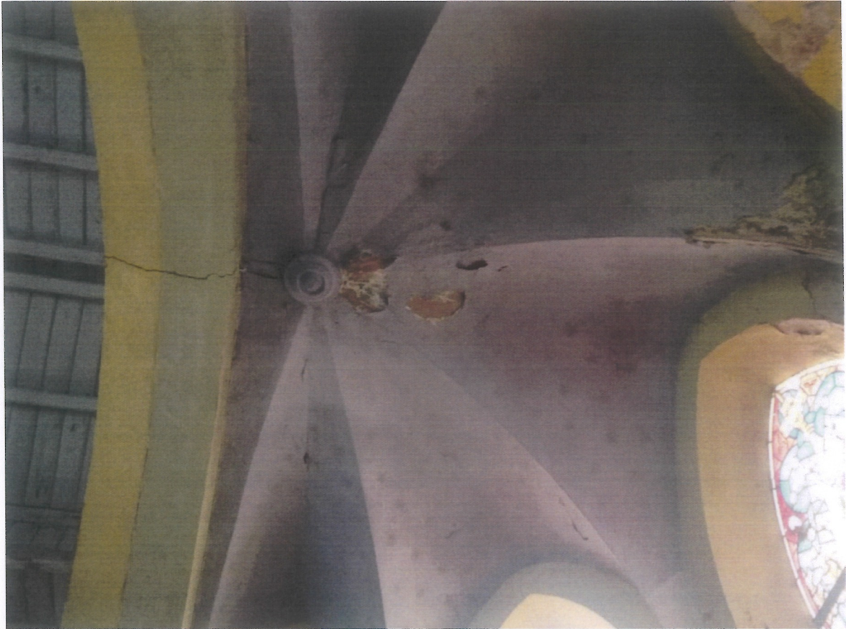
Fot. 81 (wyk. W. Tomaszewski): Widok stanu zachowania fragmentu łuku tęcowego oraz sklepienia prezbiterium. Przy zworniku samoczynnie odsłonięty fragment pozostałości dekoracji malarskiej
