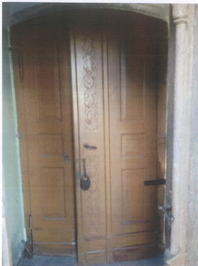
Fot. 71 i 72 (wyk. W. Tomaszewski): Ogólny widok obecnego stanu zachowania obydwu stron drzwi wewnętrznych. Kompozycja stolarska jest kompletna i zachowana w stanie oryginalnym. Całość powierzchni pokrywa farba olejna w kolorze żółto-pomarańczowym ( miodowym ), pod którą znajdują się warstwy kolorystyczne.
