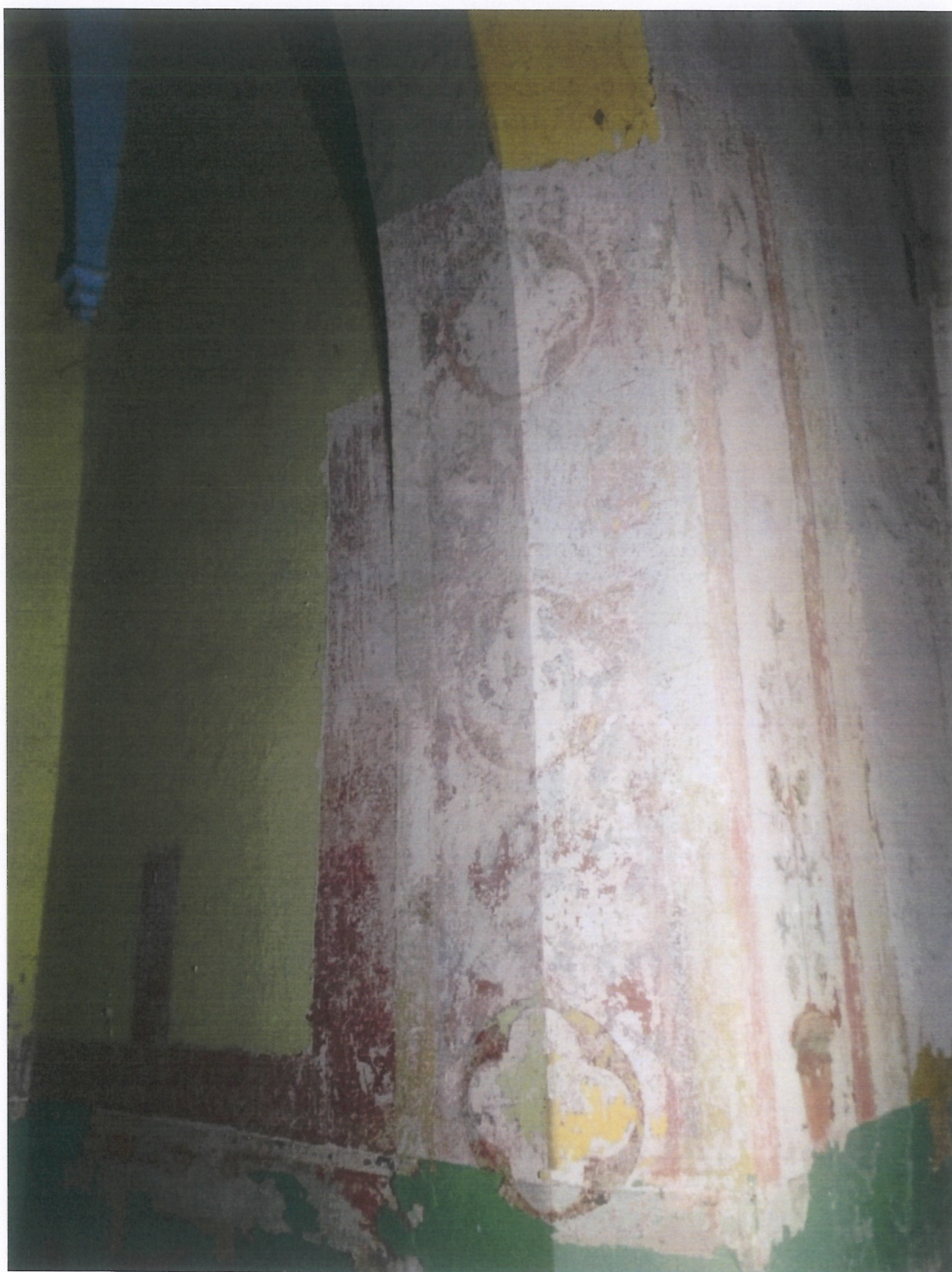
Fot. 101 (wyk. W. Tomaszewski): Odkrywka wykonana na odcinku tuku tęczowego oraz na ścianie prezbiterium.
