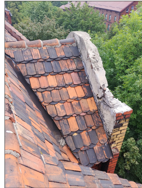
Widoczne uszkodzenia: 2, 6 Pokrycie z dachówki karpiówki przewidziane do wymiany.
