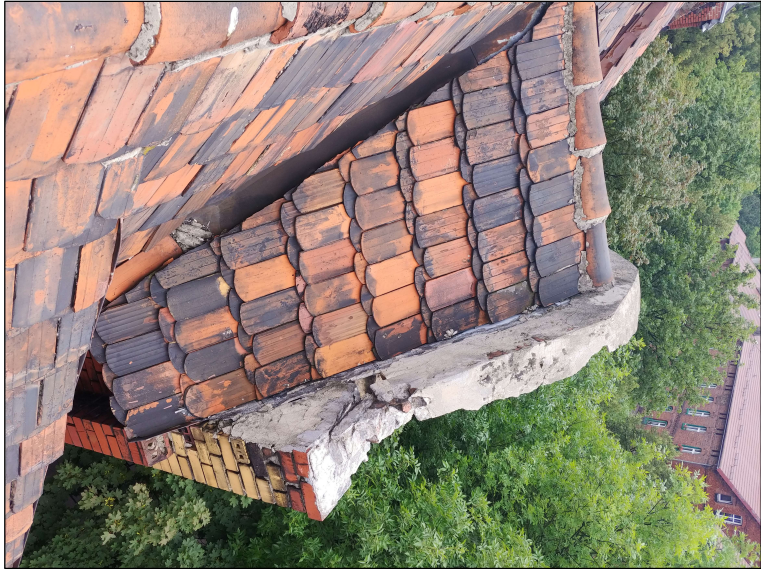
Widoczne uszkodzenia: 2, 6 Pokrycie z dachówki korpiówki przewidziane do wymiany.
