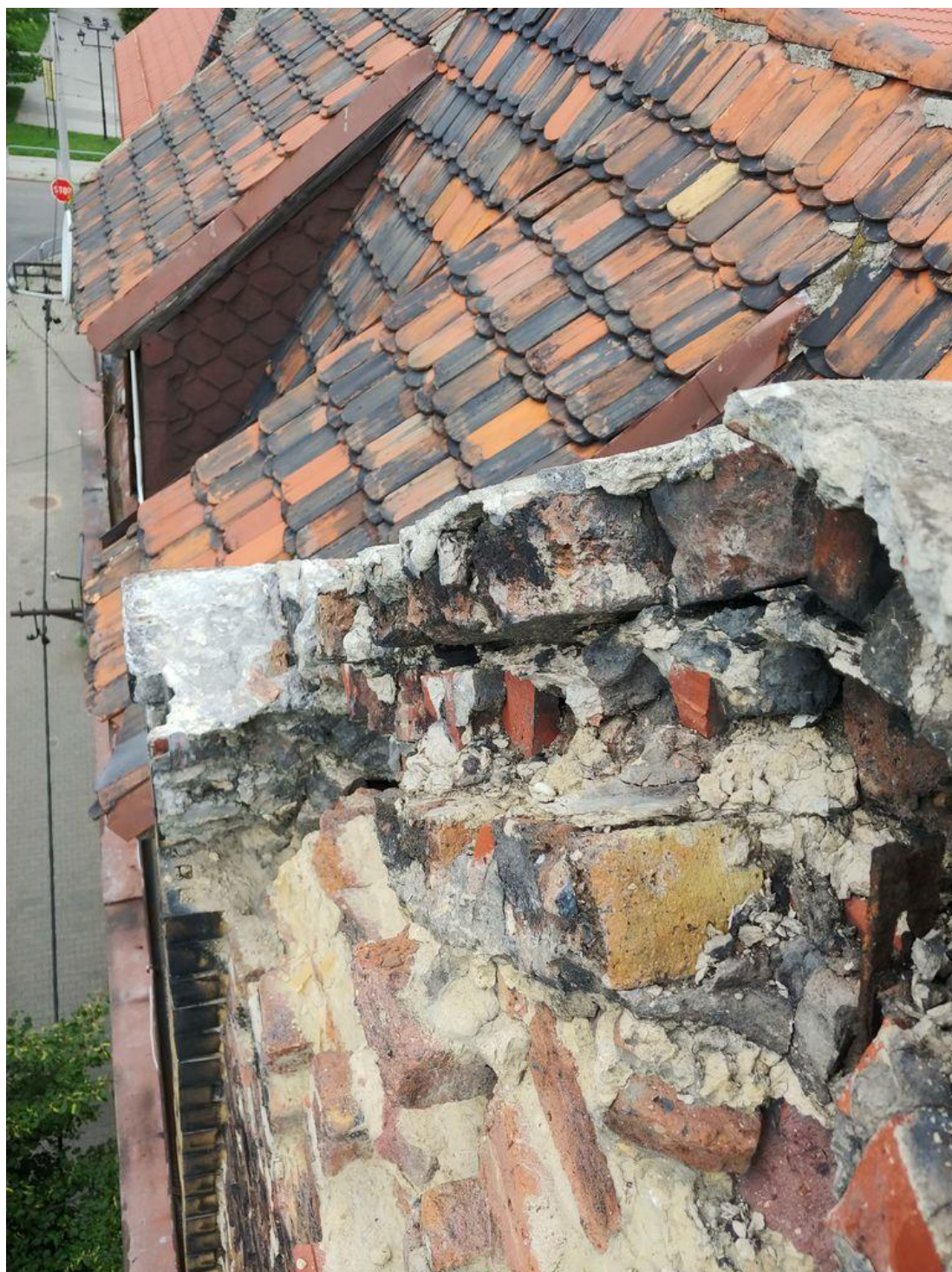
Zdj. 5 Rolkę z cegieł wykonano na mocniejszej zaprawie niż pionową płaszczyznę ściany. Zastrzeżenia jednak budzi grubość spoin.
