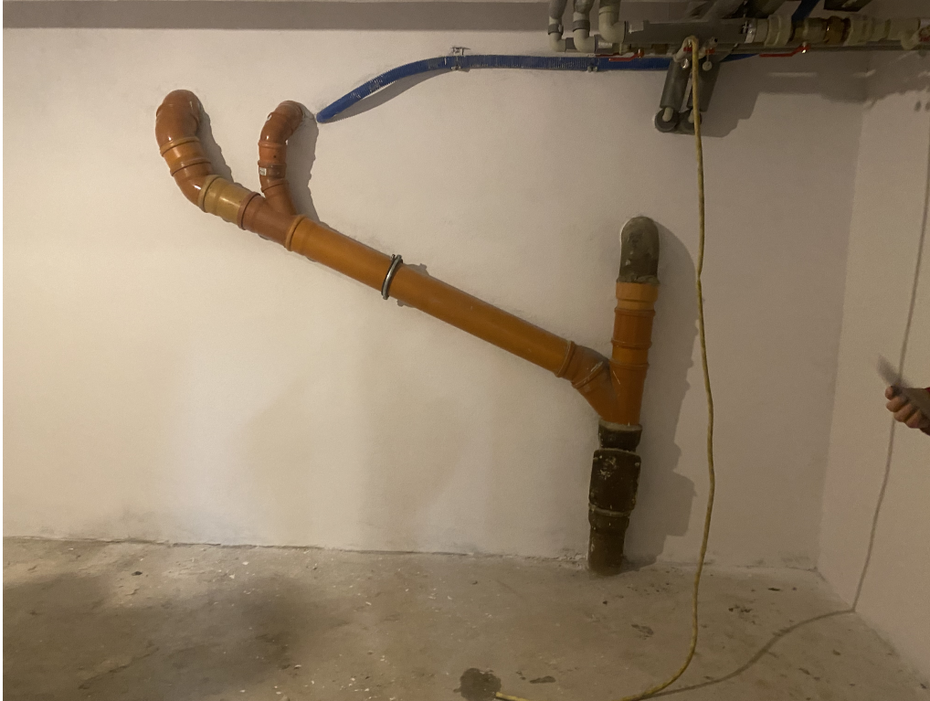
rys. Pomieszczenie, w którym zlokalizowana będzie stacja dezynfekcji ścieków.
