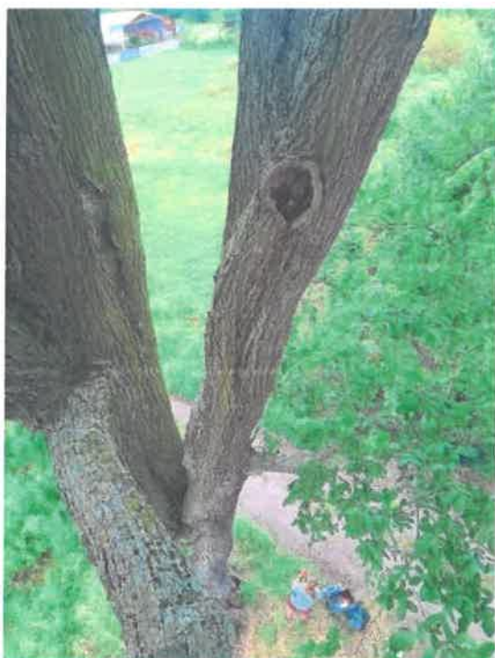
fot. 12 Ubytek na przewodniku E
