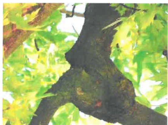
fot. 17 Uszkodzony konar na przewodniku SW
