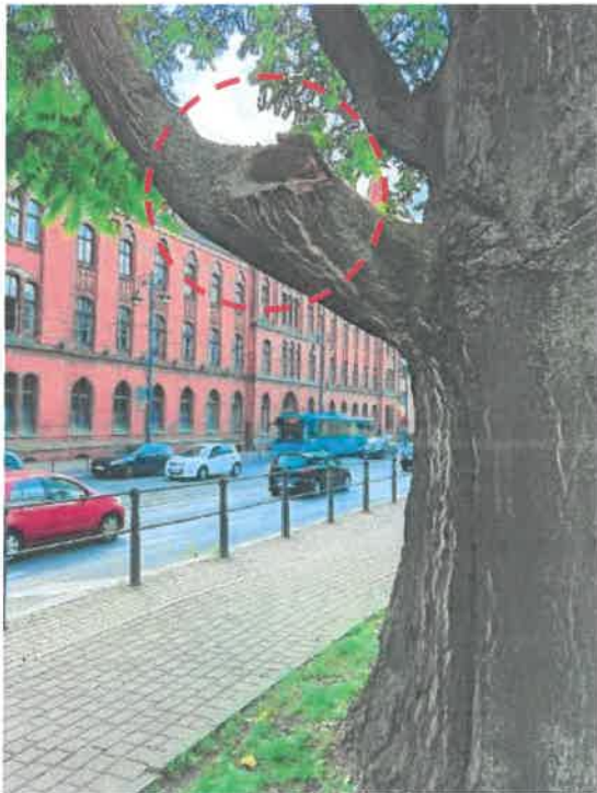
fot. 6 Najniższy konar SE z zaznaczonym ubytkiem
