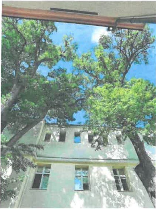
fot. 12 Kollisiona przewodnika N z sąsiednim drzewem
