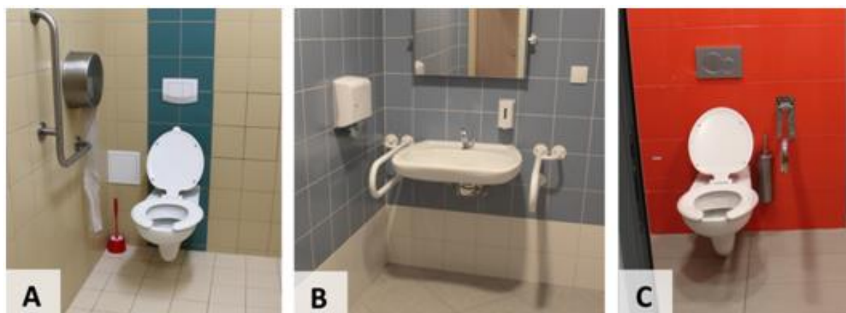
Rysunek 58. Przykład zastosowania kontrastów kolorystycznych w pomieszczeniach sanitarnych [fot.: N. Ratajczak-Szponik, Dostosowanie polskich szkół z początku XXI wieku do potrzeb dzieci z niepełnosprawnościami ..., op.cit., s. 275].
