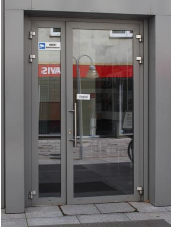
Rysunek 10A. Przykład kształtowania uchwytów przy drzwiach – uchwyt pionowy [fot.: N. Ratajczak-Szponik].
