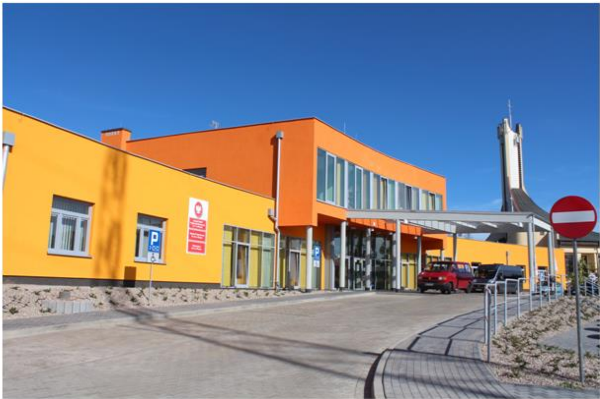
Rysunek 37. Przykład usytuowania i zaaranżowania strefy czasowego postoju przy wejściu do budynku [fot. N. Ratajczak-Szponik].
