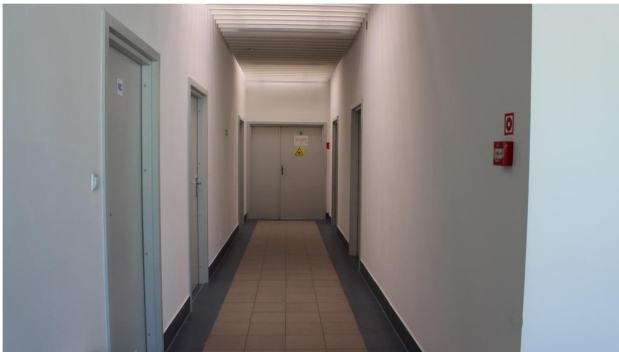
Rysunek 29. Przykład posadzki o matowym wykończeniu i liniach kontrastowych wzdłuż korytarza [fot. N. Ratajczak-Szponik].
