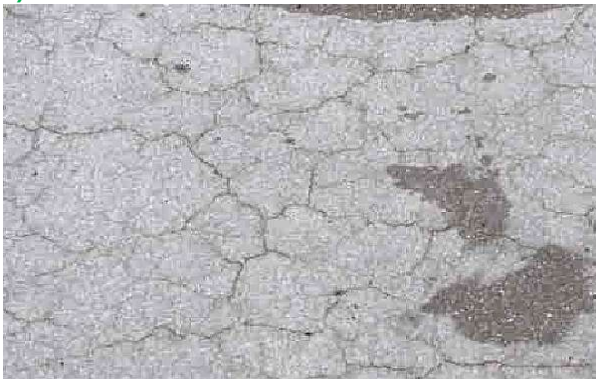
Rys. 6.2.3.2. Widok pęknięć mrozowych: a) w postaci nieregularnej siatki; b) przy krawędzi płyty
