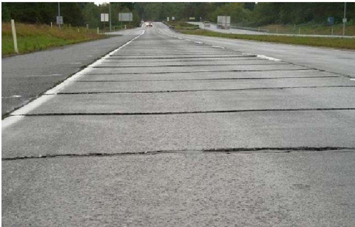
Rys. 6.2.1.6. Widok uskoków płyt
