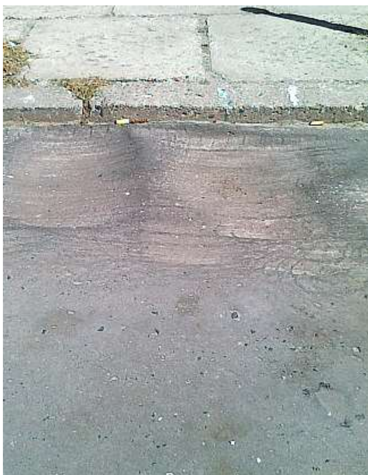
Rys. 6.1.1.3. Deformacje trwałe – odciski
