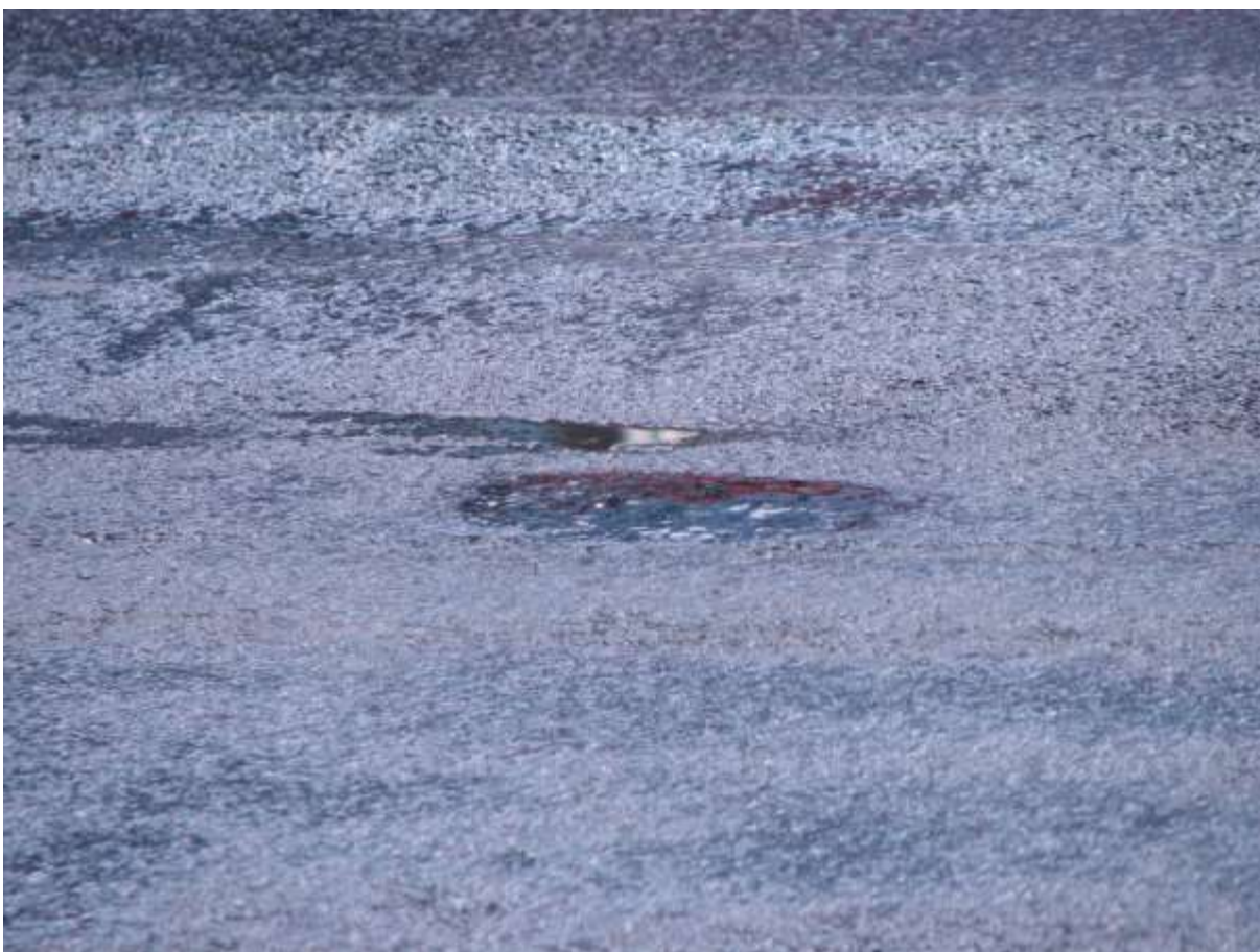
Rys. 6.1.3.8. Wyptyw (plamy) lepiszcza
