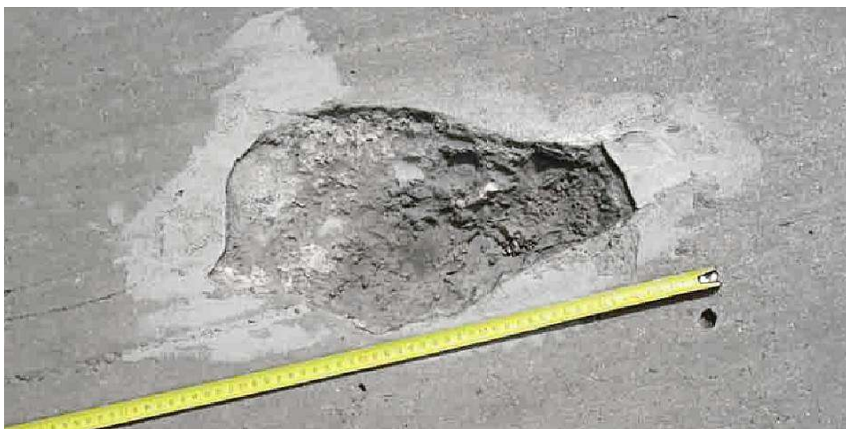
Rys. 6.2.3.8. Widok wyboju
