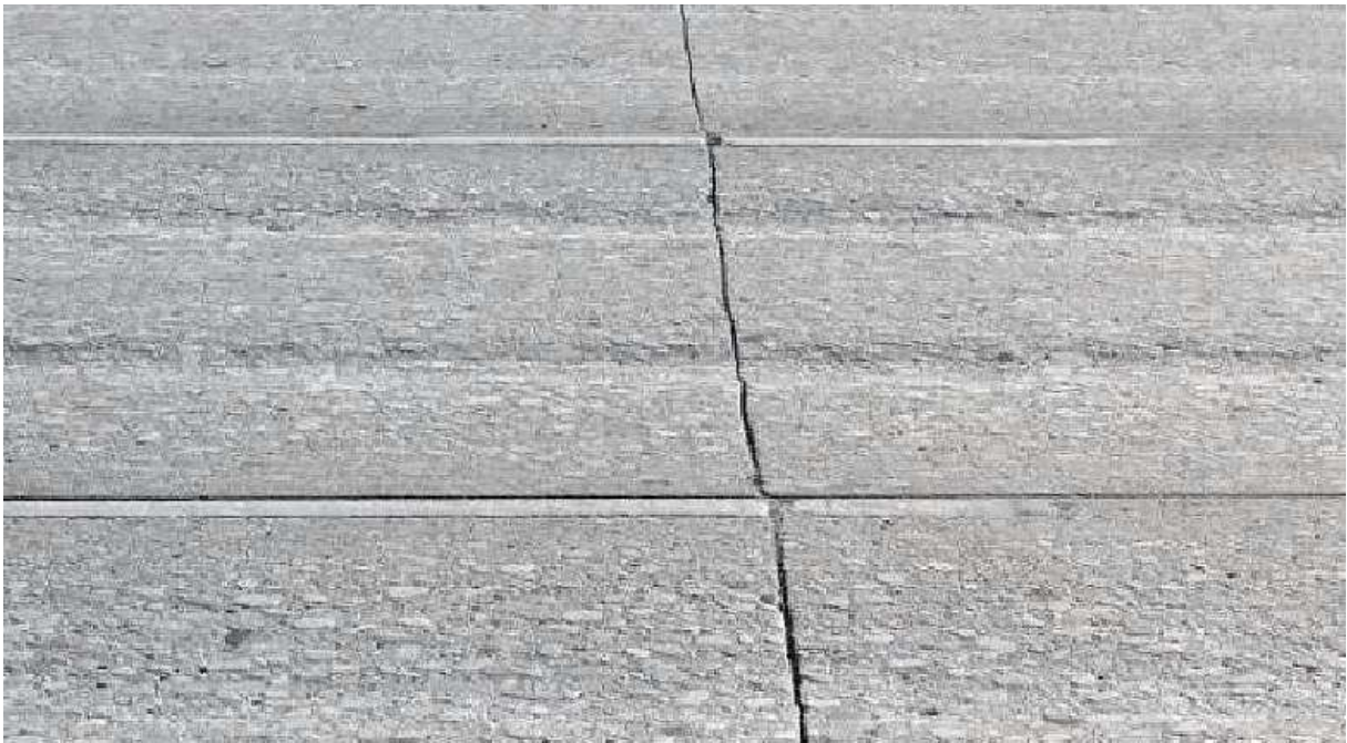
Rys. 6.2.1.1. Widok poprzecznych deformacji trwałych
