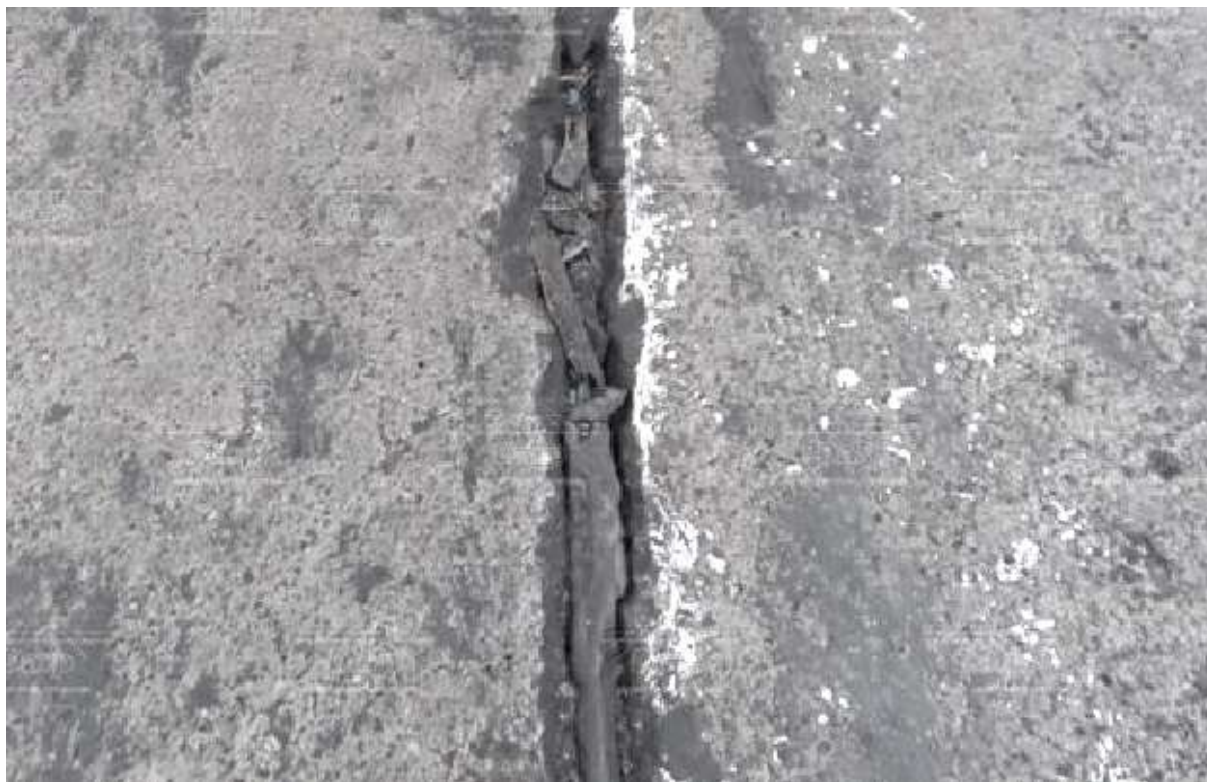
Rys. 6.2.4.4. Widok uszkodzenia wypełnień w szczelinie
