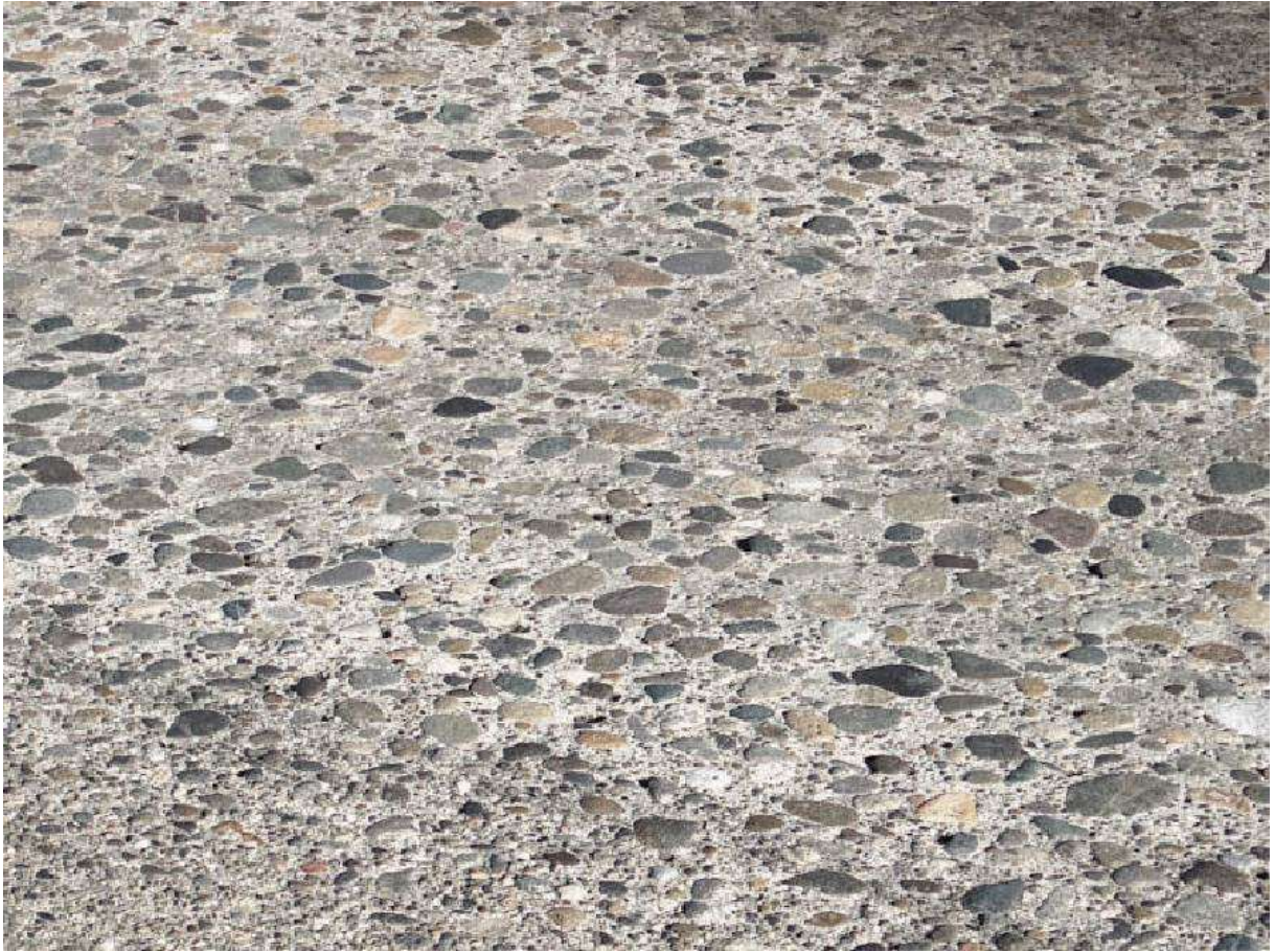
Rys. 6.2.3.1. Widok wypolerowanej powierzchni płyty
