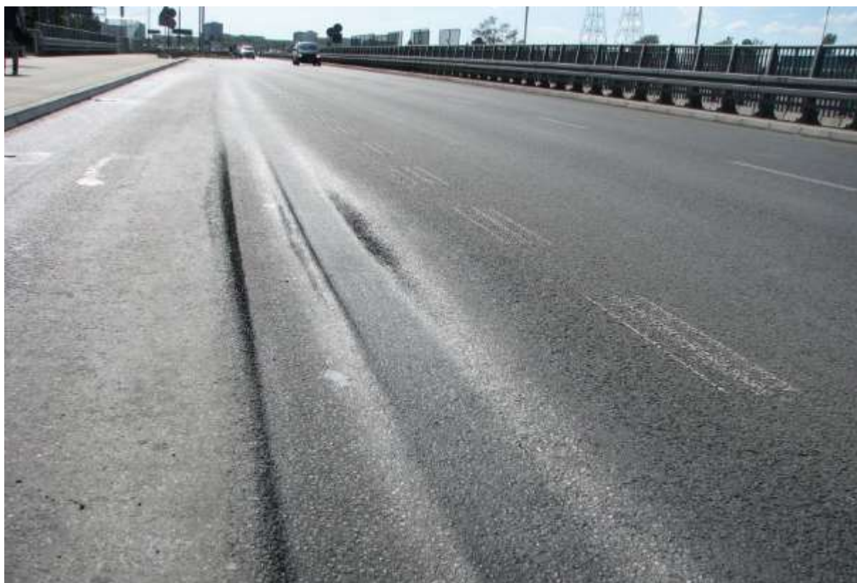
Rys. 6.1.1.1. Nierówności poprzeczne lepkoplastyczne
