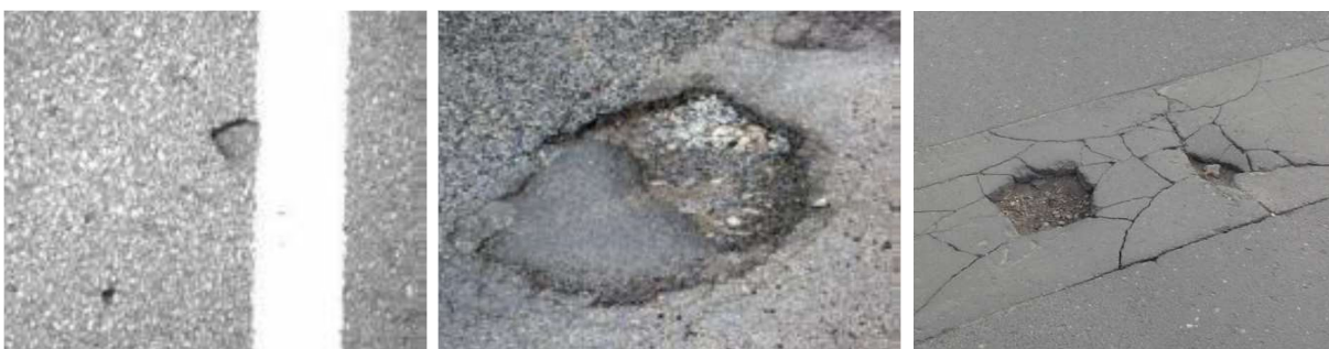
Rys. 6.1.3.3. Przykłady wybojów [2]
