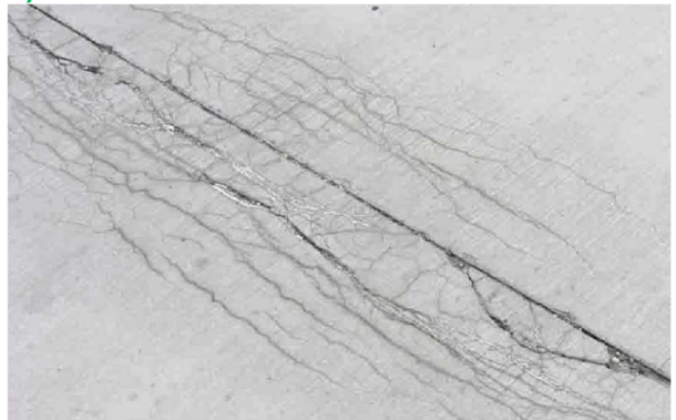
Rys. 6.2.3.2. Widok pęknięć mrozowych: a) w postaci nieregularnej siatki; b) przy krawędzi płyty
