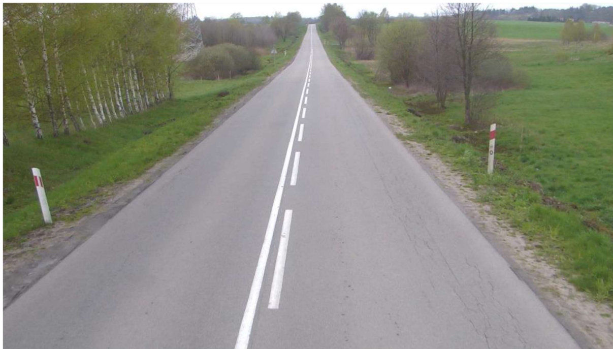
Rys. 6.1.2.2. Stan niezadawalający: skupiska spękań siatkowych zajmujące do 15% powierzchni [2]
