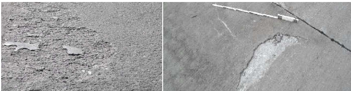
Rys. 6.2.3.11. Widok złuszczeń
